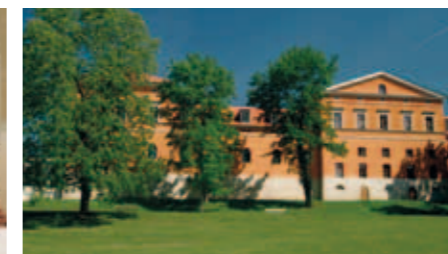
Marstallgebäude mit Park
